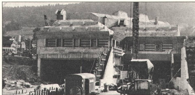
Tunnel-Rohbau Seite Weiningen mit später bepflanztem Lärmschutzwall
