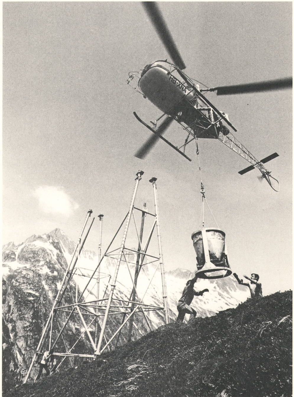
Montagearbeiten an der Lukmanier-Leitung im Val Milà
