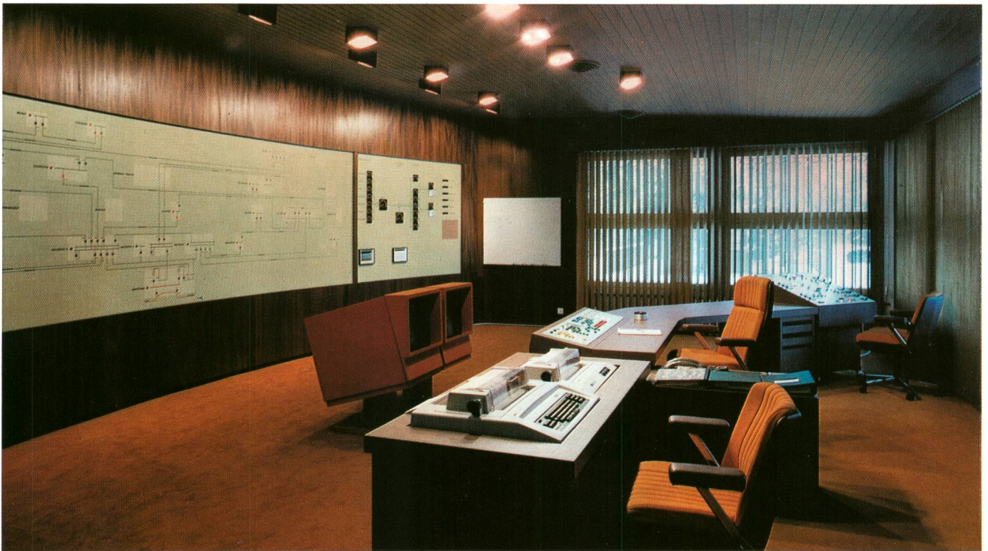
Netzleitstelle der Elektrizitätswerke Freiburg.
