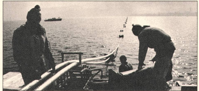
Das Kabel wird abgesenkt.
