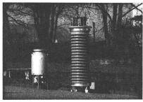
GASCOIL - eine neue Messwandlergeneration mit SF<sub>6</sub>-Isolation.
