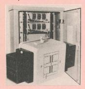
Sämtliche Kabelabschluss-Schränke sind für eine Prüfspannung von 20 kV/50 Hz ausgelegt und bieten primärund sekundärseitig mit hochspannungsfesten Schaltdrähten vorverdrahteten Übertragerschienen Platz. Jede Schiene kann bis zu drei Übertrager der Bauform 60 aufnehmen. Die Verdrahtung bietet aufgrund ihrer Auslegung die Möglichkeit, alle drei Stammübertrager durchzuschalten und Kunstschaltungen auszubilden. Die Schränke können vollständig bestückt und verdrahtet geliefert werden.
