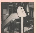
Diese Anlage ist sehr flexibel und kann für komplexe Gebäude-Konfigurationen eingesetzt werden. Sie erlaubt die dauernde und selektive Überwachung der Personal-Ein- und Ausgänge. Mehrere Sicherheitsstufen sind programmierbar und können den verschiedenen Personalarbeitszeiten und den Zutrittszonen sowohl örtlich wie zeitlich zugeordnet werden. Personalbewegungen und Alarmmeldungen werden protokolliert und bei unberechtigten Zutrittsversuchen wird Alarm ausgelöst. Weitere technische Merkmale:
