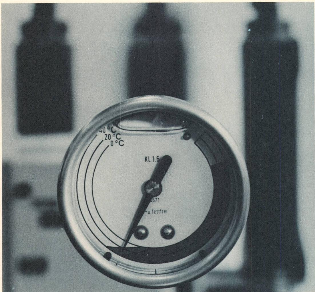
**Ein Blick informiert über den Gasdruck in den Löschkammern.**
