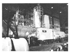
Fig. 4 Gasturbine im Ciba-Geigy-Werk Monthey Links ist der Gaseintritt in den Abhitzekessel noch zu erkennen. Der Kessel mit einer Maximalleistung von etwa 97 MW<sub>th</sub> ist nicht mehr sichtbar. In der Mitte die Turbine der Kompressor und die stehende Brennkammer. Rechts der 27-MVA-Generator und Hilfsaggregate.
