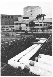
Fig. 4 Fernwärmeleitungen auf dem Inselareal Beznau
