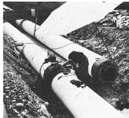
Fig. 5 Verlegung der Stahlmantelrohre
