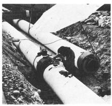
Fig. 5 Verlegung der Stahlmantelrohre
