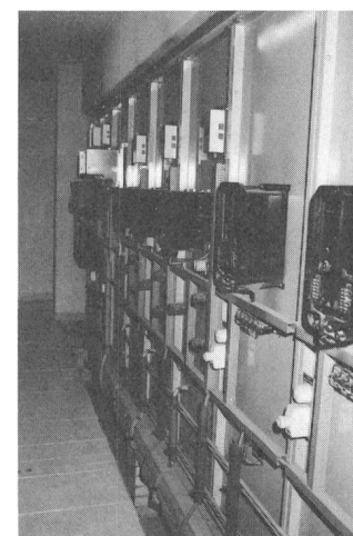
Fig. 11 Rückseitige Ansicht der Mess- und Schaltfelder in der Station Hauptgebäude
