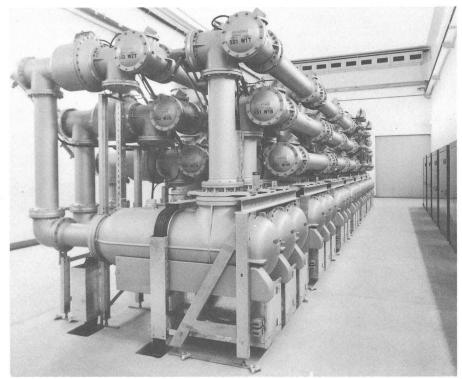
Fig. 1 Blick auf das Kuppelfeld der siebenfeldigen  ${\rm SF_6}$ -Anlage mit Doppelsammelschiene und Längstrennung
