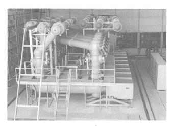
Anordnung und Schaltfeld einer 525-kV-Schaltanlage Kraftwerk Itaipu in Brasilien, von Brown Boveri Oben: Schaltfeld einer 1½-Schalter-Anordnung Unten:
