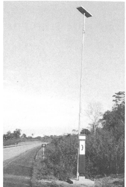
Fig. 4 Notrufsäule mit Antennenmast und Sonnenenergiespeisung
