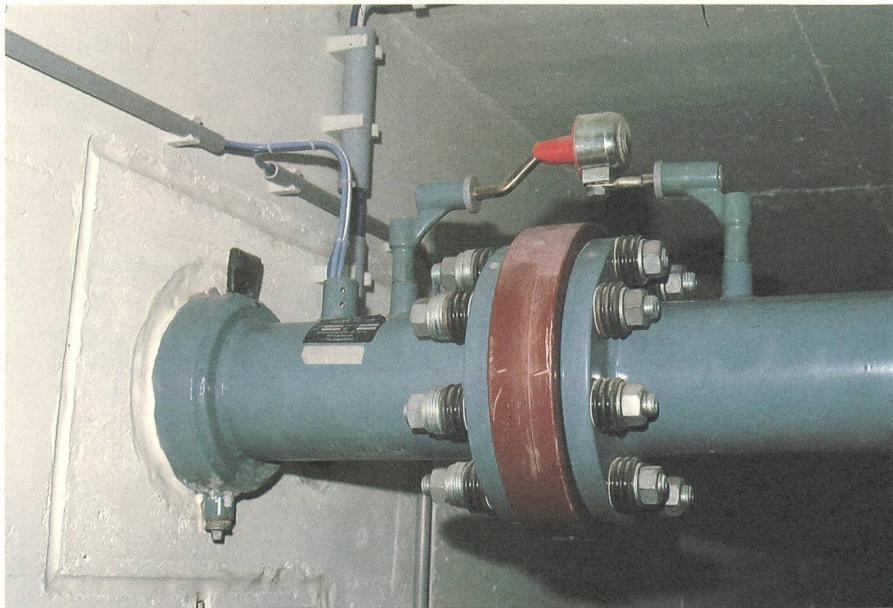
Conduite de carburant protégée cathodiquement, pourvue d'un joint isolant muni d'un électeur
