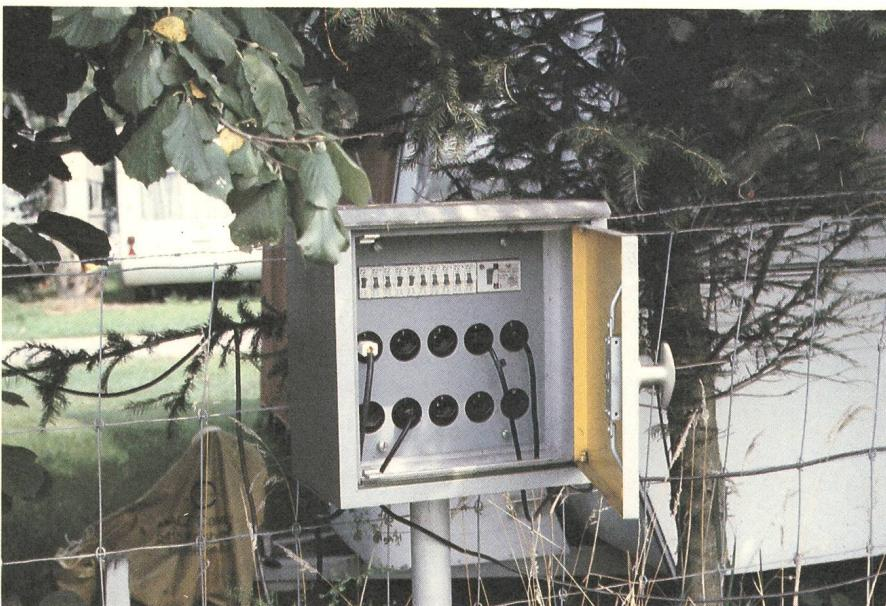
Coffret d'alimentation pour place de camping avec disjoncteur de protection à courant de défaut, et disjoncteurs contre les courts-circuits
