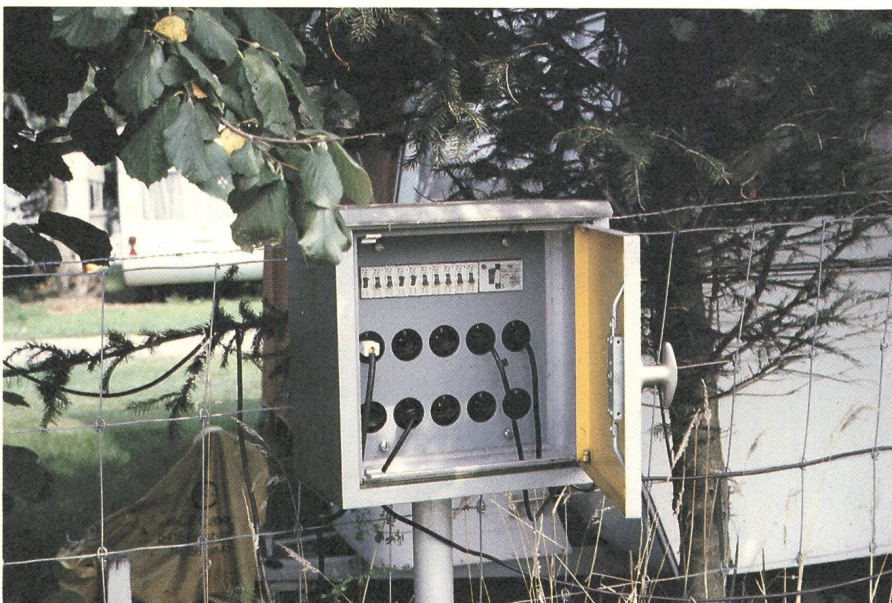
Mit Leitungs- und Fehlerstrom-Schutzschaltern geschützte Anschlussstellen für Campingwagen
