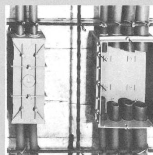
Schlaufkästen, Klemmenkästen, Apparate-Einbaukästen und T+T-Anschlusskästen mit Steckverbindungen. Zum Programm gehören auch neutrale, promovierte Blechdeckel mit Eckbefestigungslöchern.
