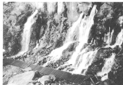
Fig. 1 Captage de la résurgence appelée «La fontaine à Moïse»
