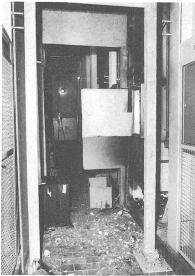
Fig. 4 Scherben und Russ kennzeichnen die zerstörte Zelle
