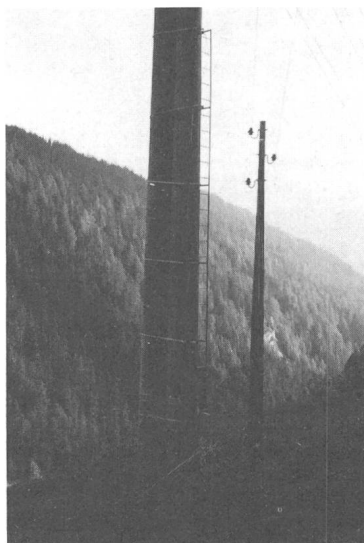
Fig. 5 Umgehungsleitung 1 m vom Mast entfernt
