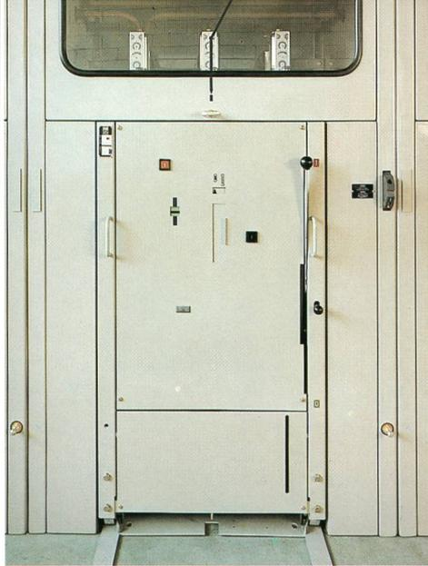
gener Hersteller. Der obere Teil der Schaltzellen (Sammelschienenraum) ist immer identisch: keine Anpassungsarbeiten beim Wechsel des Schaltertyps.
