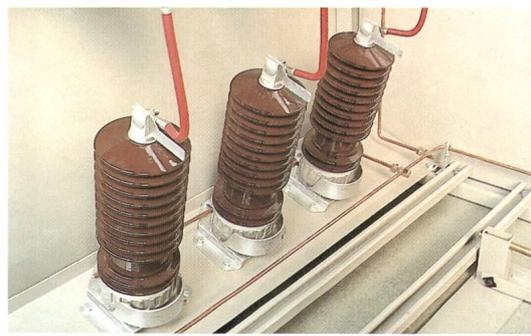
Gut zugängliche Endverschlüsse dank der platzsparenden Anordnung der Überspannungsableiter.
