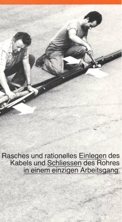
Rasches und rationelles Einlegen des Kabels und Schliessen des Rohres in einem einzigen Arbeitsgang.
