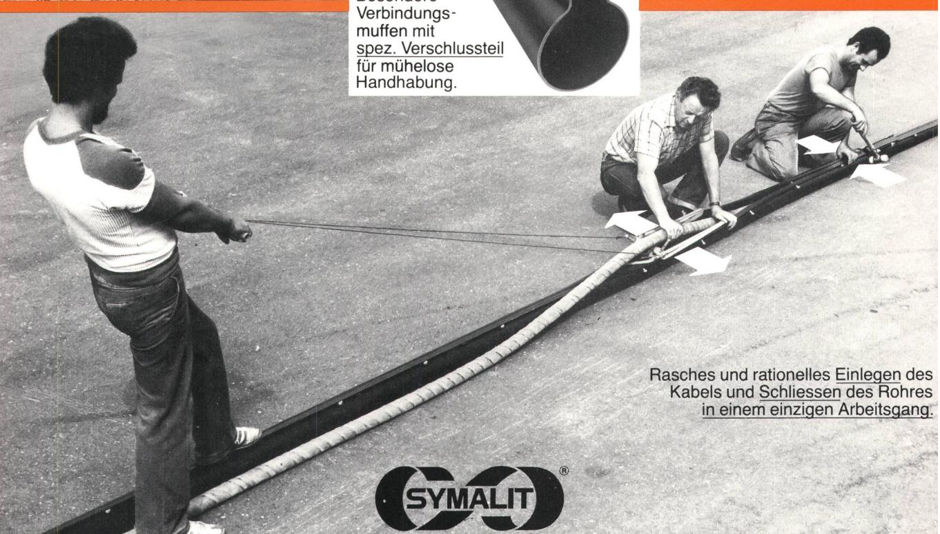
Rasches und rationelles Einlegen des Kabels und Schliessen des Rohres in einem einzigen Arbeitsgang.
