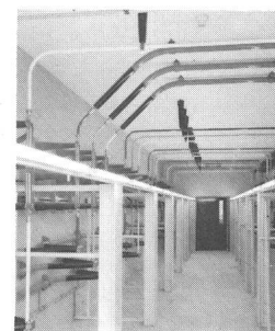
Sammelschienen 72,5 kV, 1200 A
