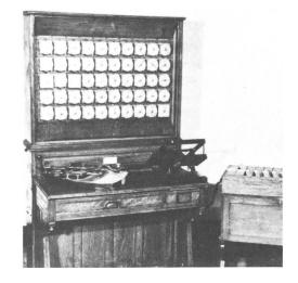
Fig. 5 Elektrische Zähl- und Registriermaschine von Hermann Hollerith
