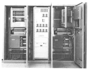
Fig. 3 Steuerschrank eines Ventilatorpaares
