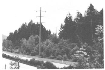
Fig. 15 Halbschneise einer 132/16-kV-Stahlvollwandmastenleitung
