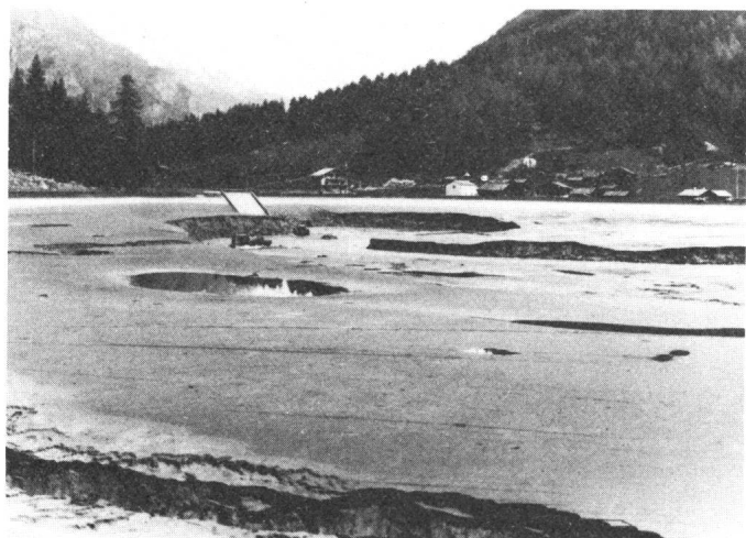
Fig. 1 Ablagerung im Ausgleichsbecken Mattsand
