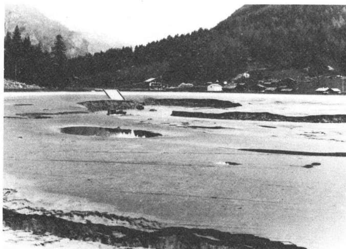
Fig. 1 Ablagerung im Ausgleichsbecken Mattsand
