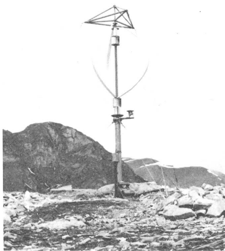
Fig. 1 Hélice de type Darrieus
