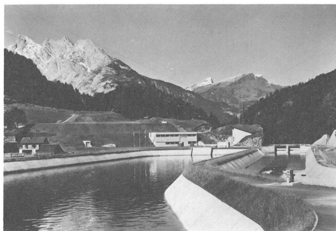
Fig. 4 Zentrale Hopflauen mit Ausgleichsbecken
