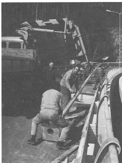
Fig. 3 Setzen von Kandelabern für die Beleuchtung der T6 in der Taubenlochschlucht
