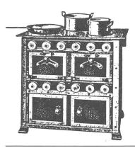
Fig. 3 Herd mit Schalterregulierung aus dem Jahre 1907 [4]
