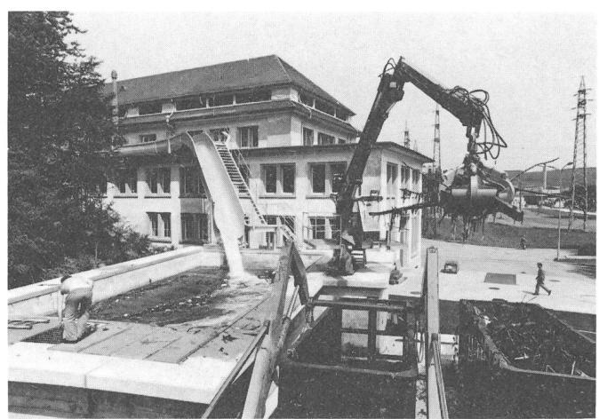
Die Anlage ist nach einer Versuchsperiode kürzlich definitiv in Betrieb genommen worden. Obwohl keine ausgeprägten Hochwasser zu verzeichnen waren, sind in dieser Zeit bereits beträchtliche Mengen Geschwemmsel abgeführt worden. Dies obwohl in den oberliegenden Anlagen Flumenthal und Bannwil bereits seit längerer Zeit das Treibgut auch herausgenommen wird.
