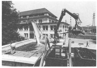
Die Anlage ist nach einer Versuchsperiode kürzlich definitiv in Betrieb genommen worden. Obschon keine ausgeprägten Hochwasser zu verzeichnen waren, sind in dieser Zeit bereits beträchtliche Mengen Geschwemmsel abgeführt worden. Dies obschon in den oberliegenden Anlagen Flumenthal und Bannwil bereits seit längerer Zeit das Treibgut auch herausgenommen wird.
