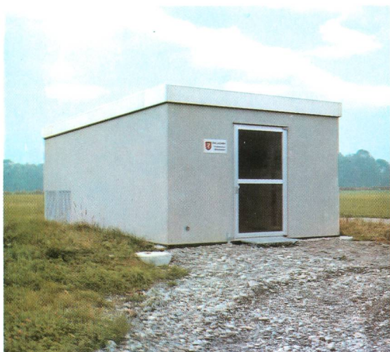
Überflur-Trafostation EW Lachen
