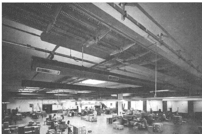
Kabelbahnen und Stromschienen in einem Industriebetrieb
