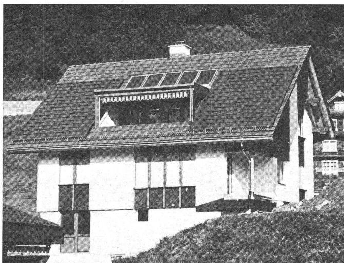
Energiedachanlage mit Absorberflächen und Sonnenkollektoren
