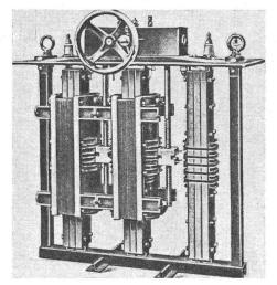
Fig. 18 Dreiphasen-Schubtransformator aus der Zeit um 1925. Koch & Sterzel AG, Dresden [39]
