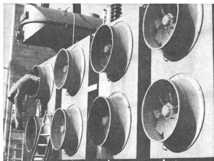
toren mit einem Flügeldurchmesser von 850 mm und einer Fördermenge von 26000 m³/h pro Ventilator. Dieser anspruchsvolle Lieferauftrag wurde an die *AWAG A. Widmer AG*, 8036 Zürich, vergeben.
