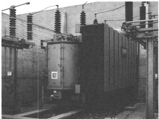
Leistungstransformator für Unterwerk in der BRD,
