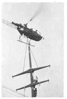
Fig. 8 Mise en place d'une console avec une Alouette LAMA
