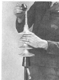
Problemlose Montage eines aufschiebbarer Freiluft-Kabelend- abschlusses
