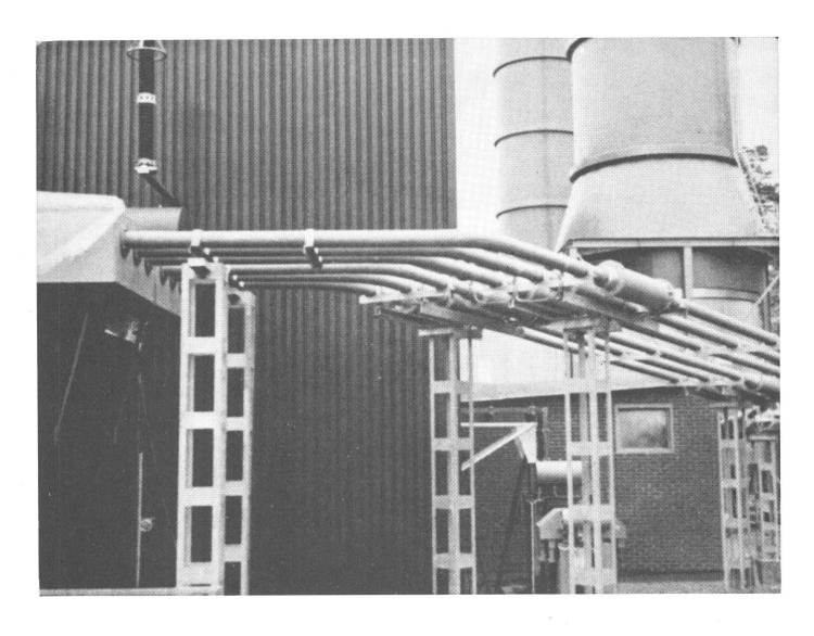
Vollisolierte Generatorausleitungen 17,5 kV 4,8 kA in einem thermischen Kraftwerk in Schweden
