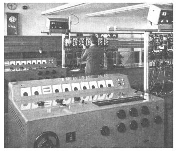
Fig. 5 Zählereichstationen mit den ersten elektronischen Zählgeräten (1959)
