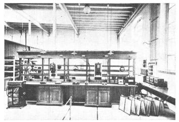
Fig. 3 Eichgestell für Einphasenzähler um 1905
