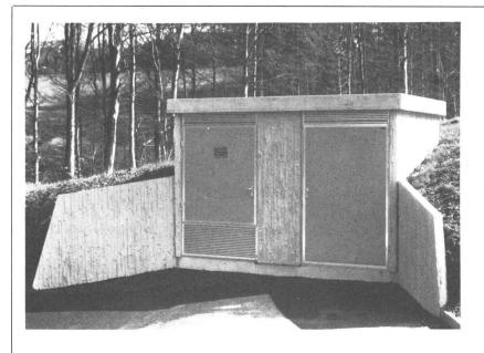
Eine Weiterentwicklung unserer Firma, Transformatorenstation Typ Modern II für Hangeinbau mit seitlichen Stützmauern. Ausbau mit 2 Leistungsschalterzellen, Lasttrenner für Leitungsabgang und Trafoschalter, Transformerleistung bis 1×1000 kVA (Typ Modern II)
