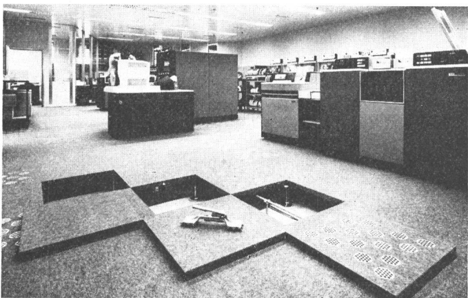
In Doppelböden verlegte Versorgungs- und Informationsleitungen
