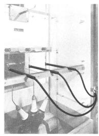
Erdungs- und Kurzschliess-Garnituren für Hoch- und Niederspannungs-Anlagen
