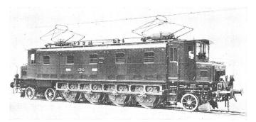
Fig. 8 Schnellzuglokomotive Ae 4/7 der SBB (1927)
