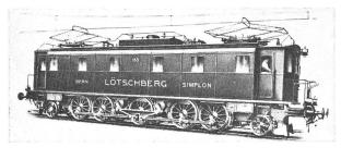
Fig. 5 Streckenlokomotive Be 5/7 mit Achsfolge 1E1 der BLS (1913)
