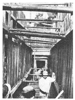
Fig. 22 Bau des Kabelstollens für ein zweisträngiges 220-kV-Kabel
