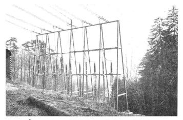
Fig. 21 Übergangsbauwerk Kabelleitung-Freileitung 220 kV
