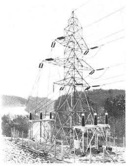
Fig. 20 Übergang Freileitung–Kabel
