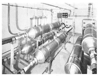
Fig. 18 Sperrmuffenschacht der 150-kV-Ölkabelanlage des EW Bern
