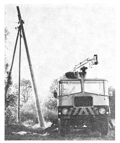
Fig. 3 Aufstellen eines Betonmastes mit Hilfe eines Kranfahrzeuges. Wegen ungenügender Verankerung geriet der Mast in die Freileitung. Beim Absteigen vom Fahrzeug wurde der Kranfahrer getötet
