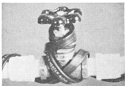
rungen aus Kupferlitze ermöglichen ein beliebiges Ablängen des Heizbandes auf der Baustelle (keine kalten Enden mehr!). Damit wird die Projektierung von Begleitheizungssystemen erheblich vereinfacht und die Montage beschleunigt. Wichtige Einsatzgebiete sind: Frostschutz, Verhindern von Kondenswasserbildung, Aufrechterhaltung von Prozesstemperaturen usw.
