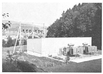
Fig. 2 132/16-kV-Unterstation Deisswil Typenbezeichnung C/S
