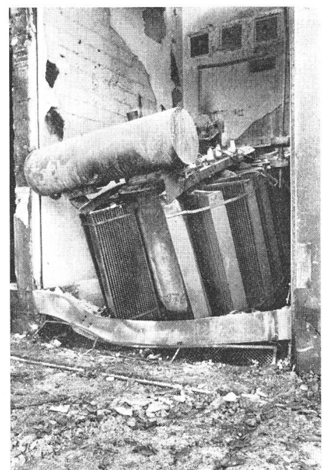
Fig. 2 Zerstörte Transformatorzelle im Unterwerk Aathal
