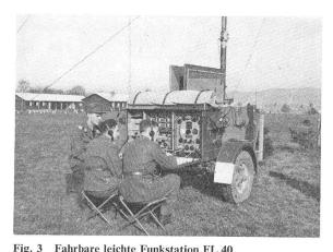
Konstruktionsjahr 1939. Amplitudenmodulierte Kurz- und Langwellenstation 100 W
