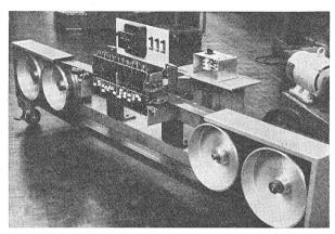
Fig. 7 Dreiphasiger Linearmotor mit Bandläufer
