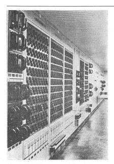
Fig. 5 Schalttafeln und Linienwähler der Maschinenhalle
